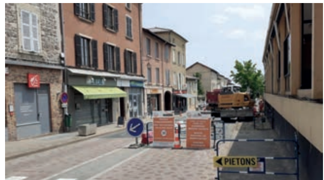
Travaux d'assainissement dans le centre bourg de Saint-Étienne-des-Oullières
